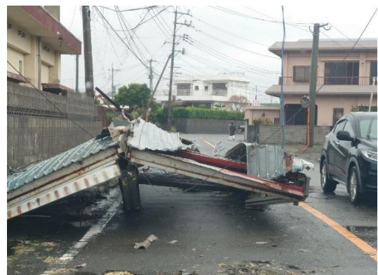
被災した鹿児島県枕崎市の様子
